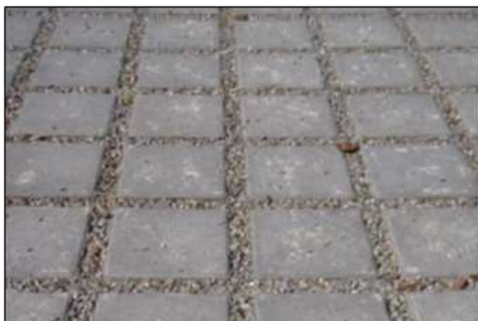
FIGUR 20. EXEMPEL PÅ GENOMSLÄPPLIG BETONBELÄGGNING MED GRUSFOGAR.
