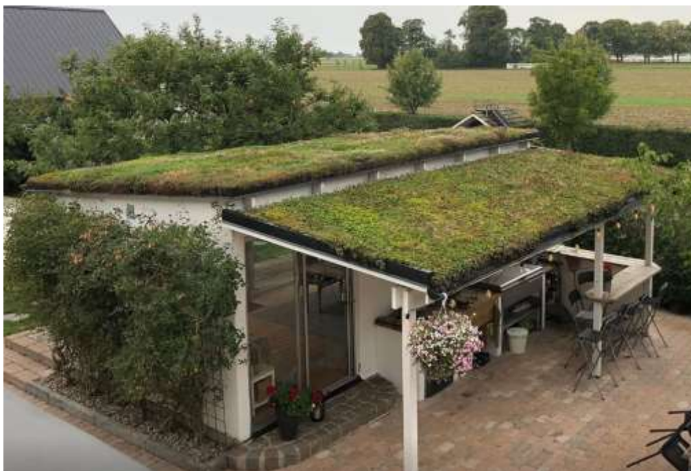
FIGUR 25. SEDUMTAK KAN ANLÄGGAS BÅDE PÅ PLATTA OCH LUTANDE TAK (SVENSKA NATURTAK AB, 2020)
